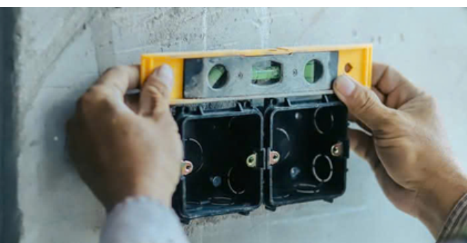
Hình ảnh: Ống cân nước đảm bảo chính xác
