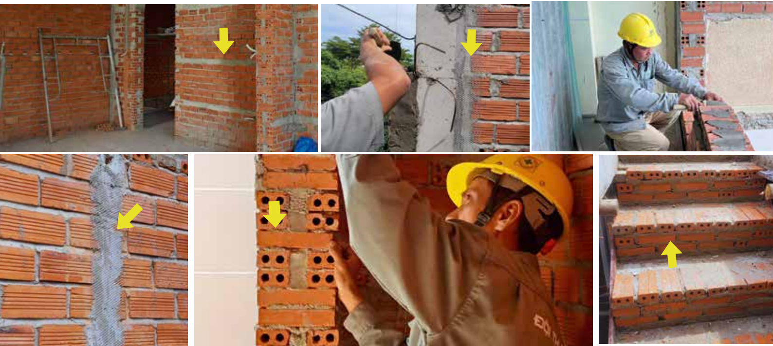
Hình ảnh: Công tác xây tường
