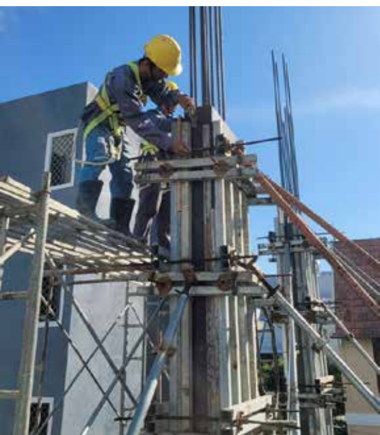
Hình ảnh: Sử dụng dây an toàn khi làm việc trên cao từ 2m trở lên.
