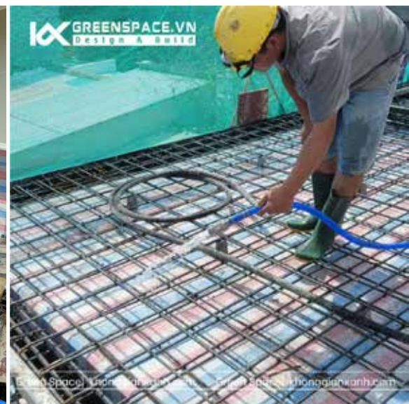
Hình ảnh: Vệ sinh - Kiểm tra sàn kỹ càng trước khi đổ bê tông
