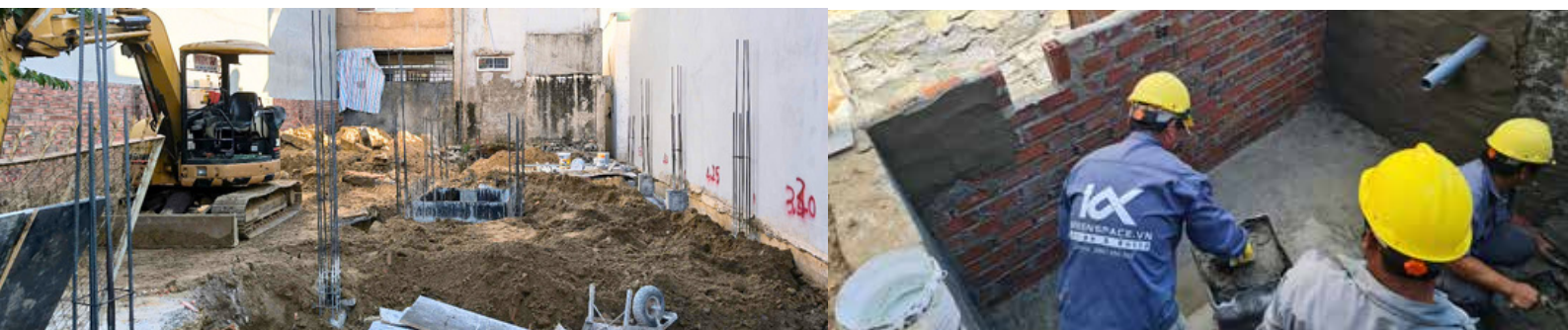
Hình ảnh: Tô trát và xử lý chống thấm bề tự hoại
