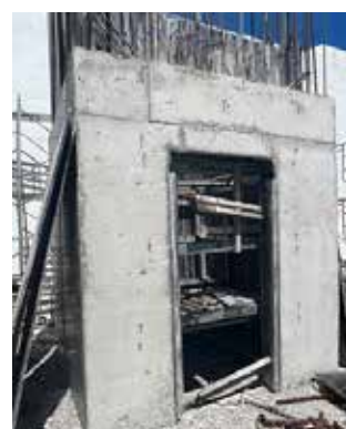
Hình ảnh: Thi công bê tông cột đúng quy chuẩn
