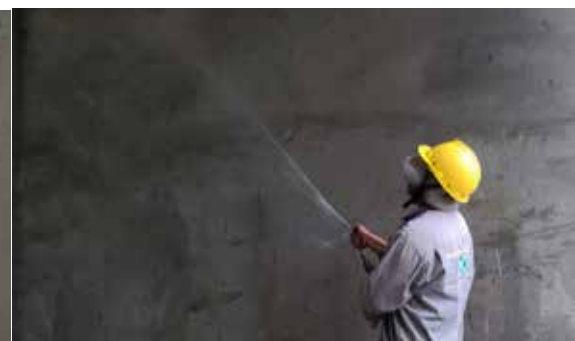
Hình ảnh: Tưới bảo dưỡng tường
