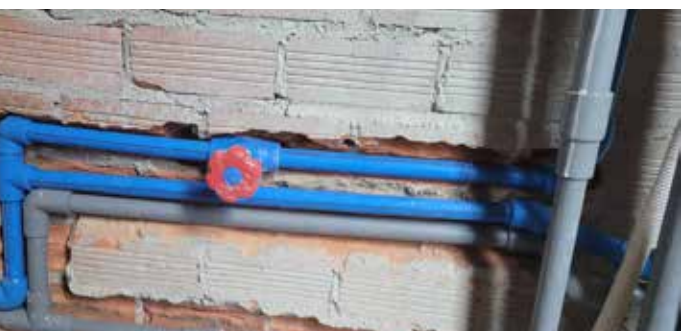
Hình ảnh: Ống nước âm sử dụng ống PPR
