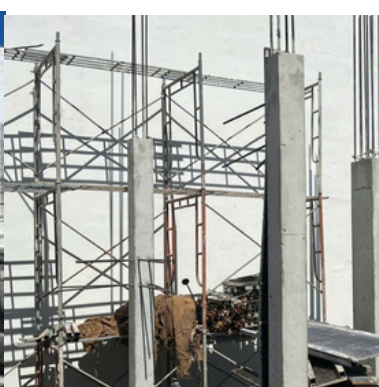
Hình ảnh: Bê tông cột sau khi tháo đảm bảo láng mịn
