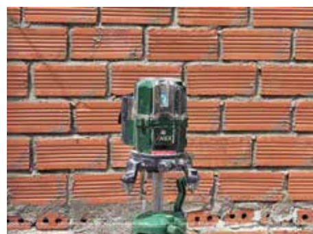
Hình ảnh: Ghém tường bằng laser
