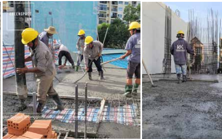
Hình ảnh: Đầm dùi liên tục khi đổ bê tông
