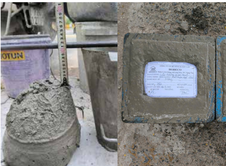
Hình ảnh: Kiểm tra cấp phối-độ sụt
