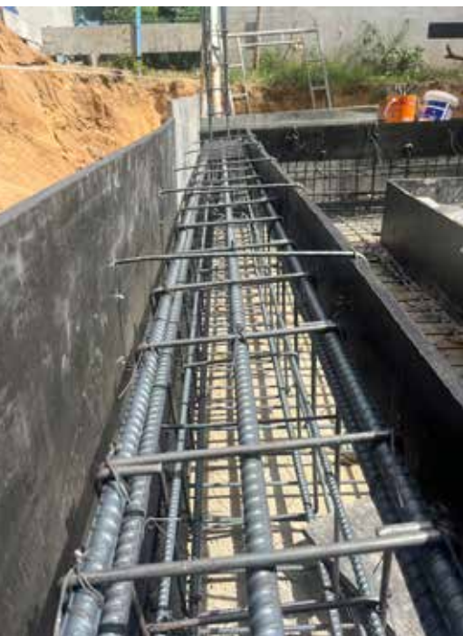
Hình ảnh: Thi công thép đà kiềng
