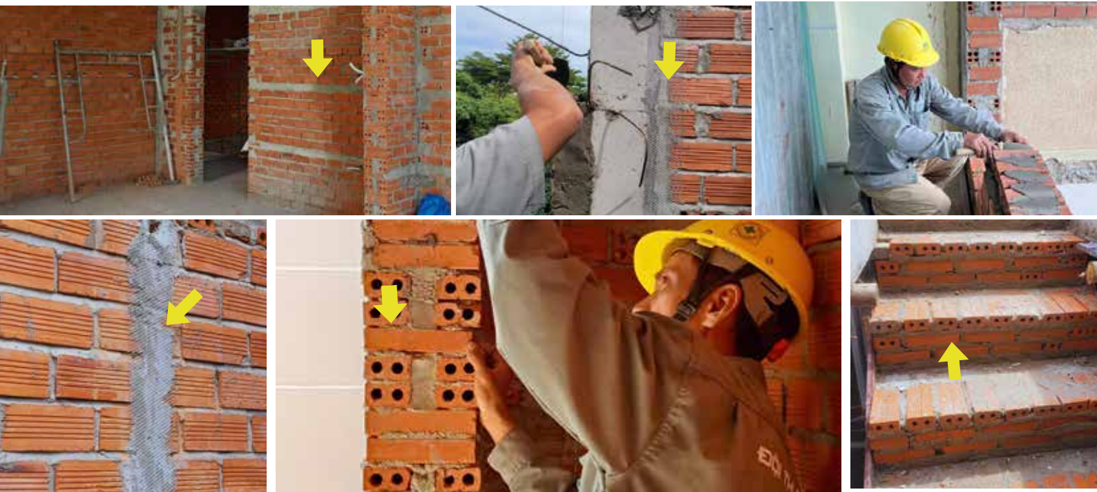
Hình ảnh: Công tác xây tường
