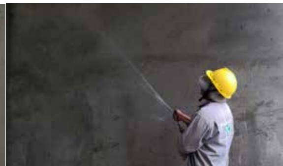
Hình ảnh: Tưới bảo dưỡng tường
