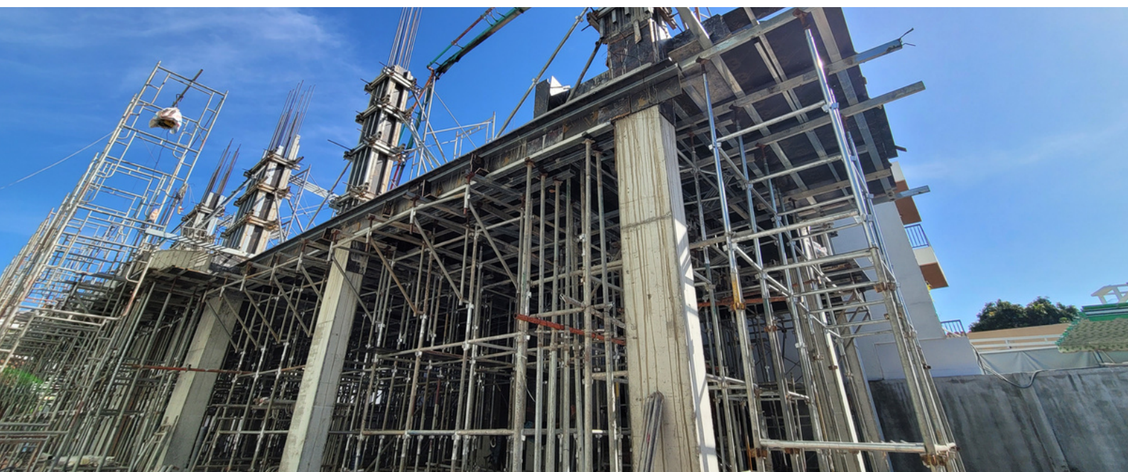
Hình ảnh: Hệ thống chống tăng được mạ kẽm
