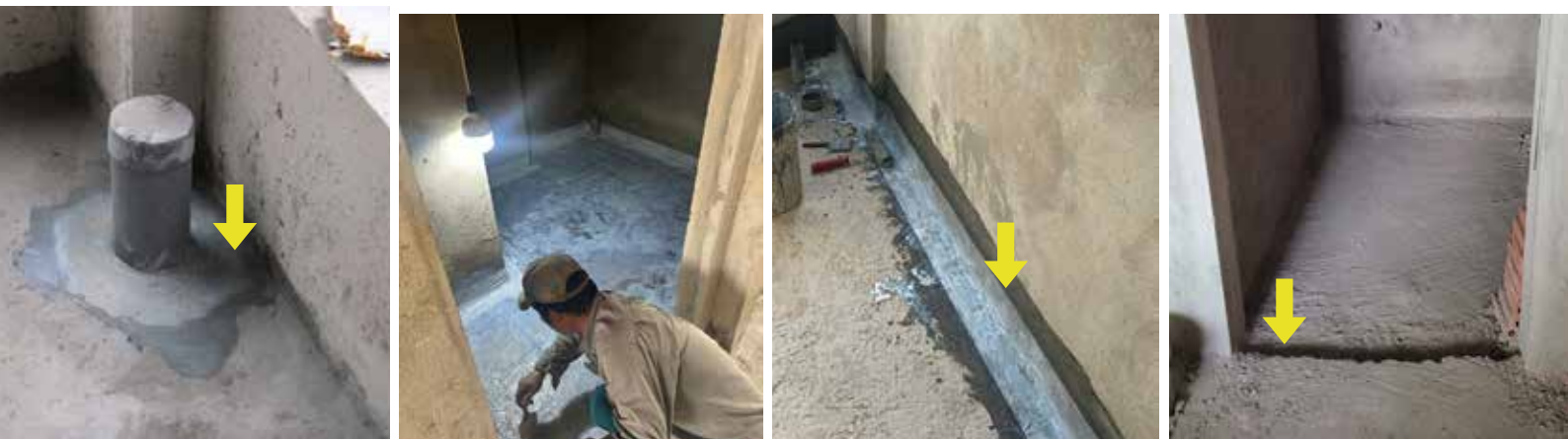
Hình ảnh: Quét chống thấm chân tường-nền WC-cổ ống
