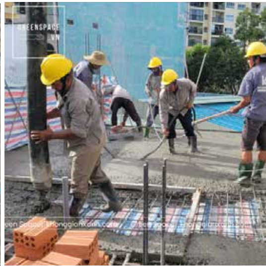
Hình ảnh: Đầm dùi liên tục khi đổ bê tông
