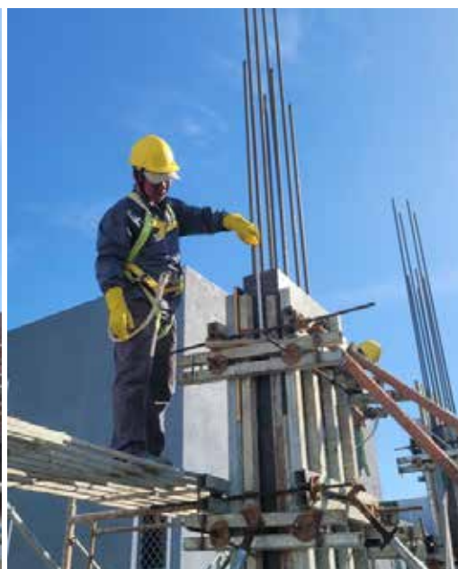
Hình ảnh: Sử dụng dây an toàn khi làm việc trên cao từ 2m trở lên.
