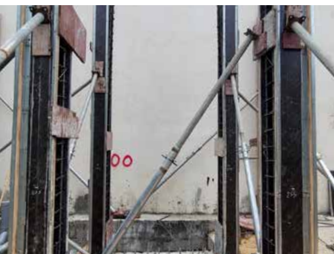
Hình ảnh: Ván khuôn được ghép cẩn thận kín, khít, đảm bảo nước & xi măng không chảy ra ngoài
