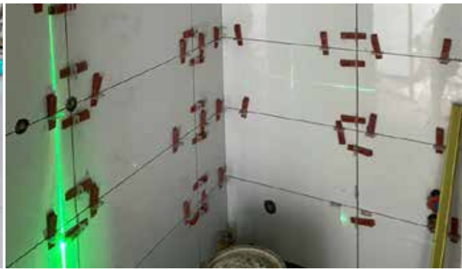
Hình ảnh: Công tác định vị và lát gạch men sử dụng ke, nêm cân bằng
