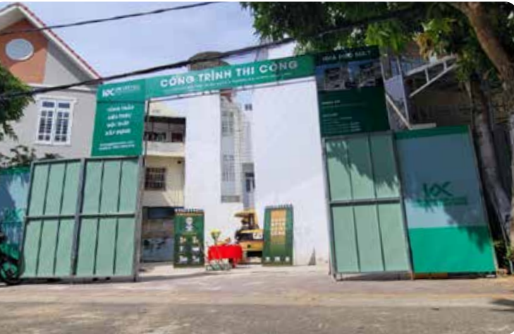
Hình ảnh: Bao che bằng tôn quay kín
