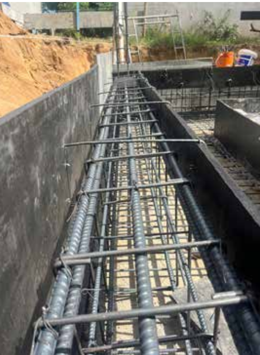
Hình ảnh: Thi công thép đà kiềng
