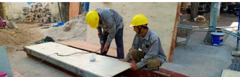
Hình ảnh: Ván khuôn được ghép cẩn thận kín, khít, đảm bảo nước & xi măng không chảy ra ngoài
