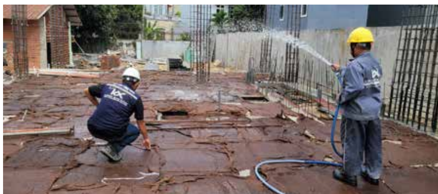
Hình ảnh: Ngâm/tưới bảo dưỡng sau khi đổ bê tông
