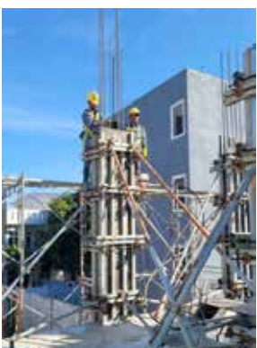
Hình ảnh: Thi công bê tông cột đúng quy chuẩn
