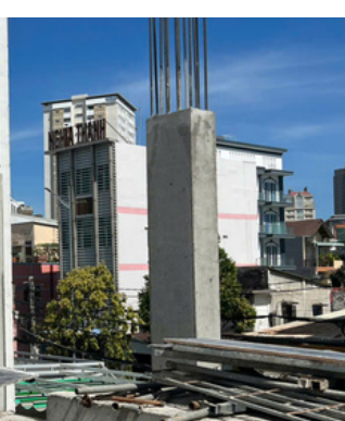
Hình ảnh: Bê tông cột sau khi tháo đảm bảo láng mịn
