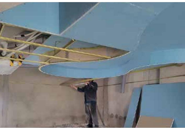
Hình ảnh: Thi công thạch cao bằng laser
