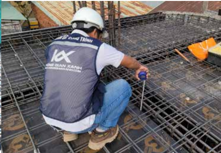
Hình ảnh: Vệ sinh - kiểm tra thép sàn trước khi đổ
