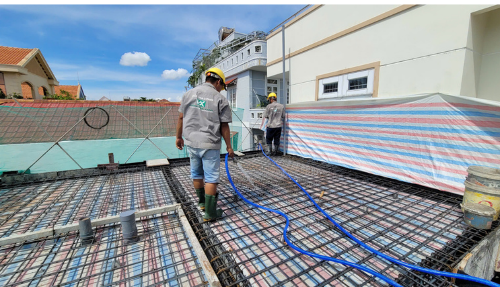
Hình ảnh: Vệ sinh - Kiểm tra sàn kỹ càng trước khi đổ bê tông
