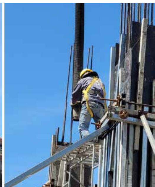
Hình ảnh: Sử dụng dây an toàn khi làm việc trên cao từ 2m trở lên.
