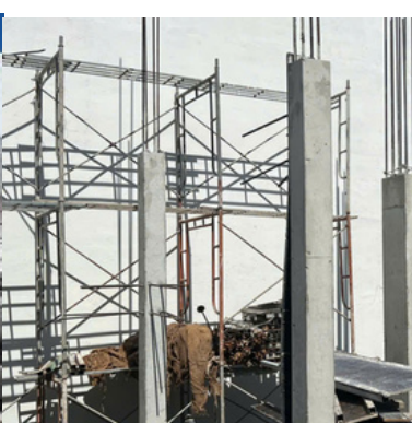
Hình ảnh: Bê tông cột sau khi tháo đảm bảo láng mịn
